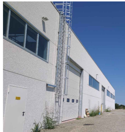
SCALA DI SICUREZZA CON GABBIA DI PROTEZIONE per salita alla copertura (ESISTENTE)
