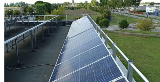
PARAPETTO DI PROTEZIONE ANTICADUTA da installare su tutto il perimetro della copertura tipo "Casarini, mod. Rapid"
